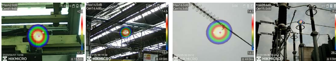
Deteção de fugas de gás
