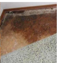
Fugas no pavimento
