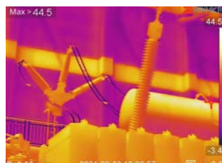
Interruptor de Isolamento
