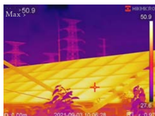
Inspeção de Painéis Solares
